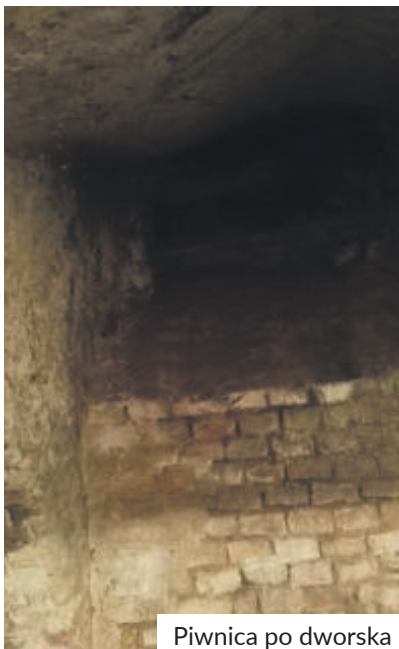
Piwnica po dworska
